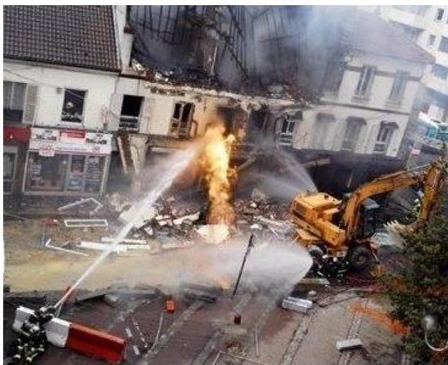
Photo : lors d'un chantier de voirie près d'un restaurant à Bondy le 30/10/2007, une pelleteuse perce accidentellement une canalisation de gaz déclenchant une explosion. Une personne est tuée et cinquante autres sont blessées.
